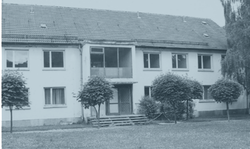
Das Wohnheim 3 vor seiner Sanierung – 1993 bekam es eine Komplettüberholung. Bis heute ist es das Zuhause von über 70 Studierenden.
