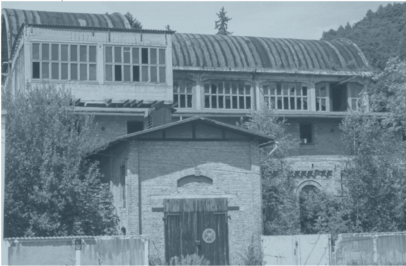
1999: Ausbau der „ehemaligen Papierfabrik“ in Wernigerode/Hasserode. Heute befinden sich darin das AudiMax, zentrale Einrichtungen und Labore des Fachbereichs Automatisierung und Informatik.
