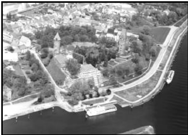
Bild 4-12: Blick auf Hafen und Burghotel Tangermünde
